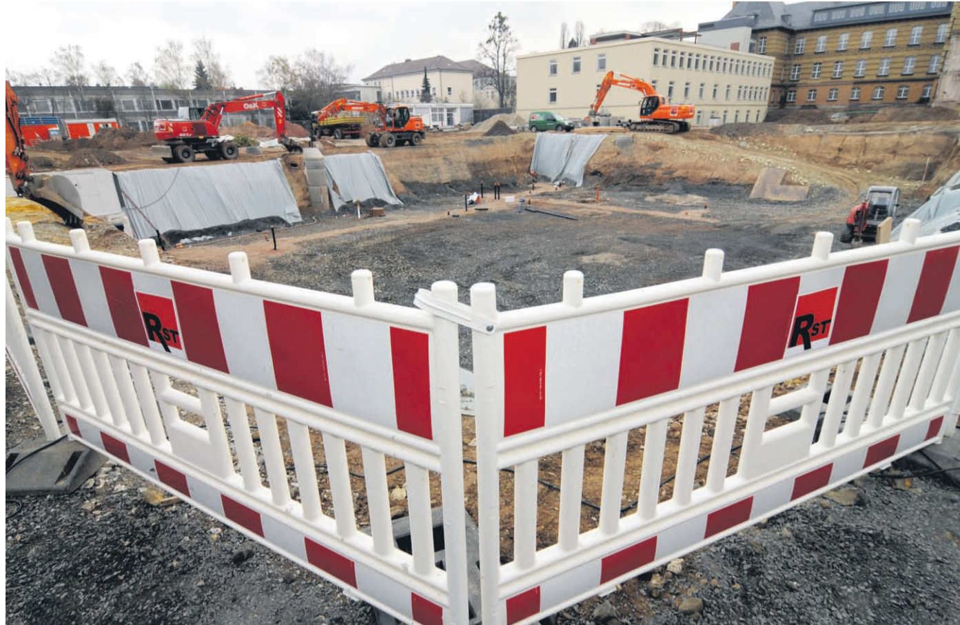
Baustelle für das neue Kulturwissenschaftliche Zentrum: 25 Millionen Euro für Seminare und Bibliothek.
